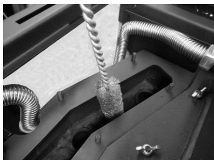
Figura 33 - Limpeza dos canais de passagem de ar e turbuladores
