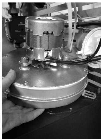
Figura 34 - a) Retirar os parafusos; b) Retirar extractor
