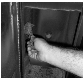
Figura 26 - Limpeza do interior da caldeira a água
