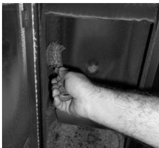
Figura 29 - Limpeza do interior da caldeira a água
